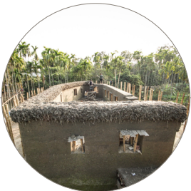
CONSTRUCTION MURS EN TORCHIS
